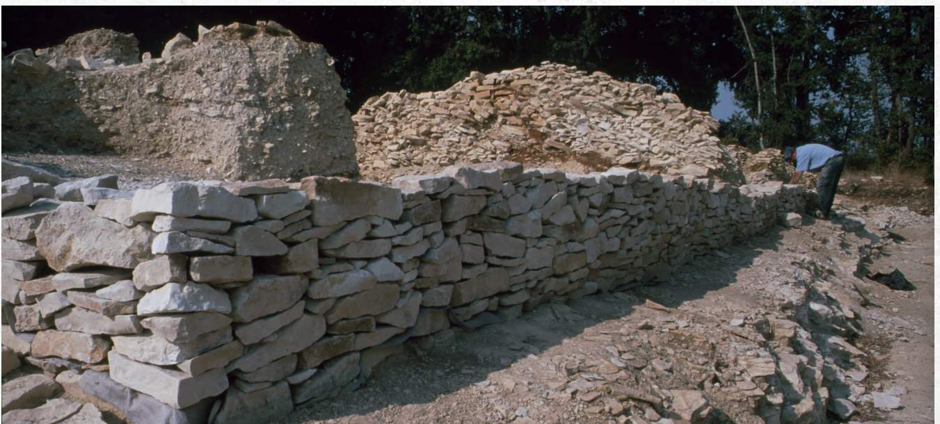
Extrémité nord-occidentale du tumulus C de Péré à Prissé-la-Charrière en cours de consolidation
