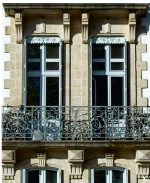
1. Garde-corps en ferronnerie indiquant les initiales du commanditaire, 6 rue Porte Prison, début du 19 e siècle. © Ville de Vannes.
