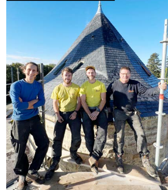
Le nouveau toit à 9 pans du manoir de Coët Candec à Locmaria-Grand-Champ fait partie des réalisations récentes de l'entreprise.
